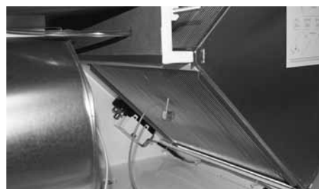
Givarens plats är markerad på värmeväxlaren (ca 5 cm från värmeväxlarens sidohörn och ca 10 cm från framkanten)
